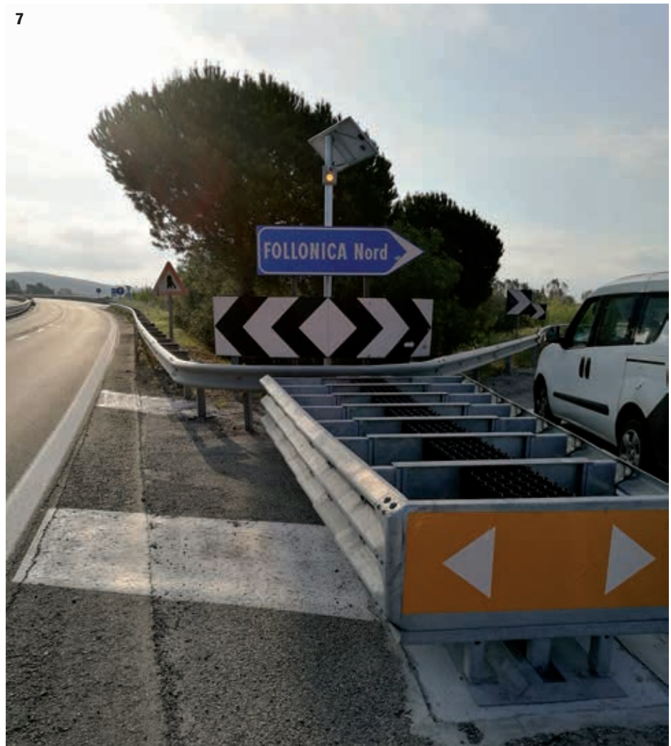
7. Il sistema di monitoraggio Geronimo installato su un'importante arteria stradale in Toscana
